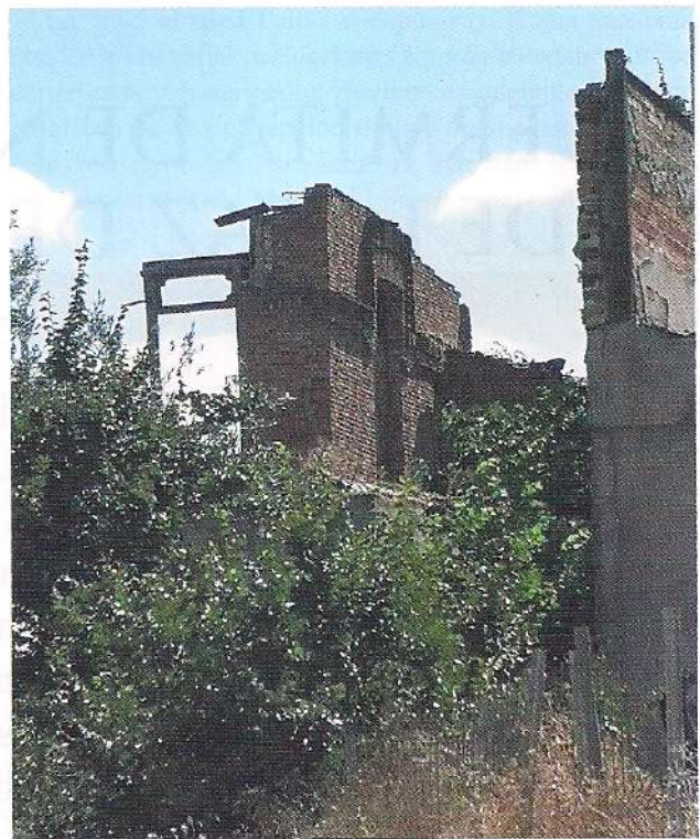
Vista del único paño neomudéjar en pie de Villa San Miguel, visible a través de la valla ubicada en la calle Duquesa de Tamames. Fuente: fotografía del autor (junio de 2020).
