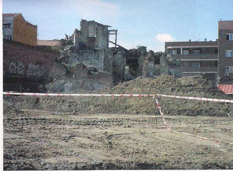
Ruinas de Villa San Miguel: un amasijo informe de maderas, muros y cascotes. Fuente: fotografía del autor (marzo de 2018).
