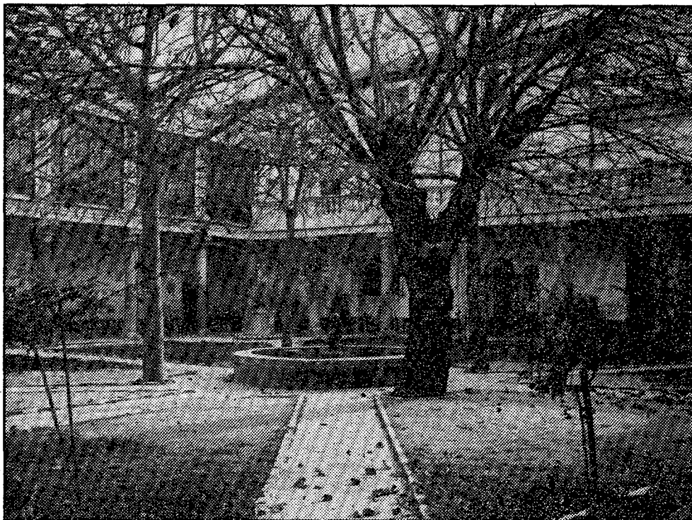
El patio andaluz del palacio de Montijo, de Carabanchel Alto, permaneció como testimonio de la arquitectura romántica hasta que llegó la piqueta y las inmobiliarias
